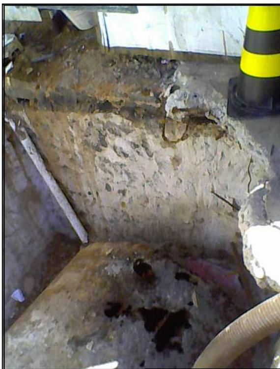
**Figura 3.3** Tanque subterrâneo de armazenamento de combustível sendo retirado devido a formação de buracos por corrosão. Fonte: Acervo de fotos do autor.
