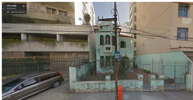
Rua do Bispo, casa vizinha ao antigo numero 329, existente até hoje no local (Foto: Google Street)
